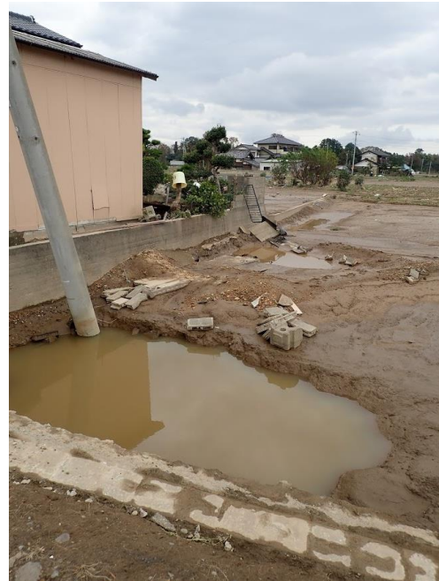
写真 2-11 道路を越える流れによる洗堀
