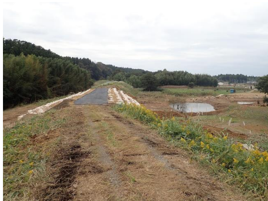
写真 2-14 藤井川破堤地点と押堀
