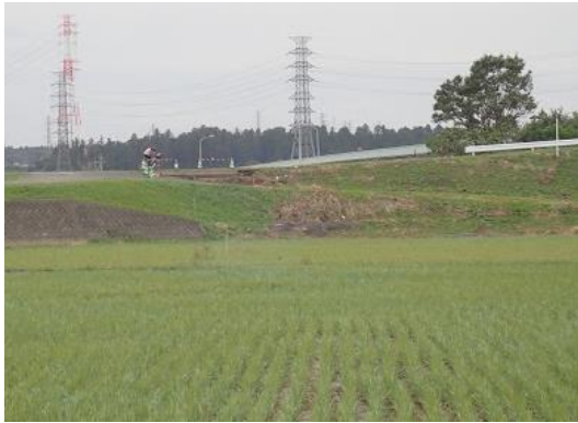
写真 2-20. 那珂川本川からの越流地点
