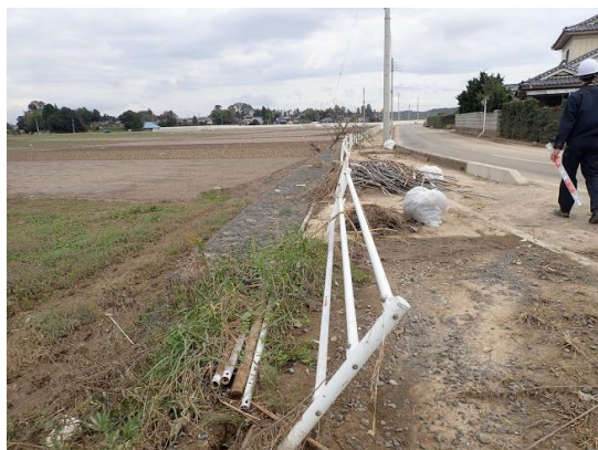
写真 2-8 南側への堀の倒れ
