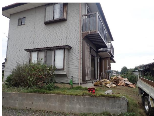
写真 3-7 家屋断熱材の取り外し作業
