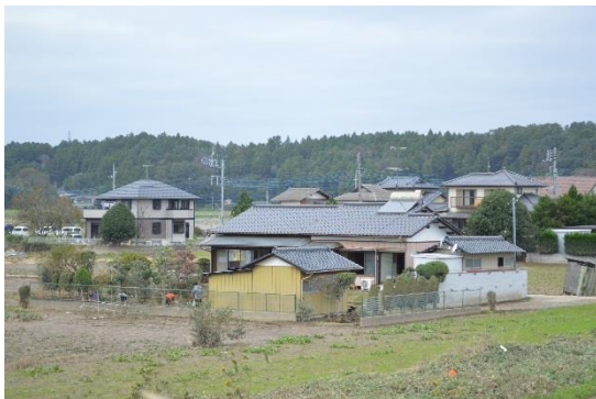
写真 3-20 住宅 C のフェンス転倒
