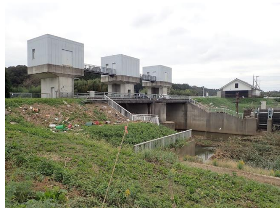
写真 2-13 西田川水門（西田川側）
