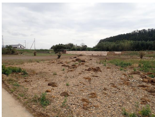
写真 2-16 氾濫流の方向を示す 堤防材料や河床材料の帯
