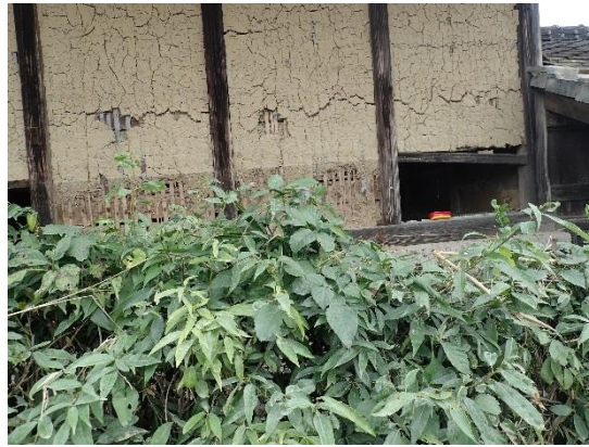
写真 3-22 壁土の流失
