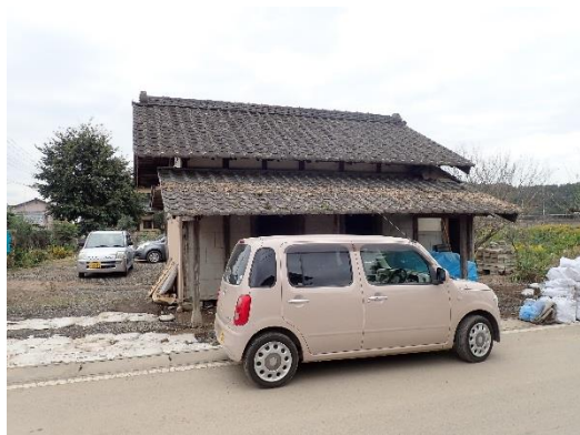
写真 3-2 1階屋根まで浸水
